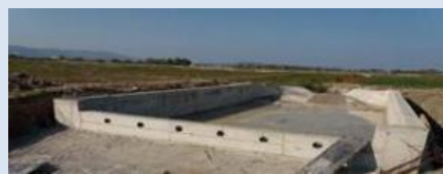
Δίκτυα Εγκατάσταση αμμοσυλλεκτών για την επεξεργασία των ομβρίων
