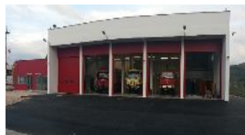
Λοιπά Νέο κτίριο για ηλεκτρομηχανικό εξοπλισμό
